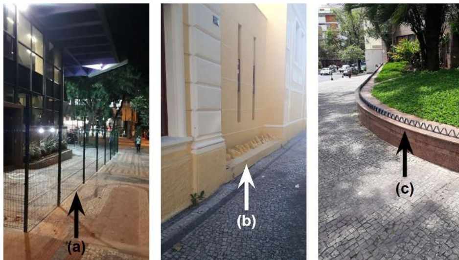
Figura 03: Dispositivos de segurança e proteção em Belo Horizonte: (a) grades, (b) pedras, (c) fincos. Crédito: Autores.
