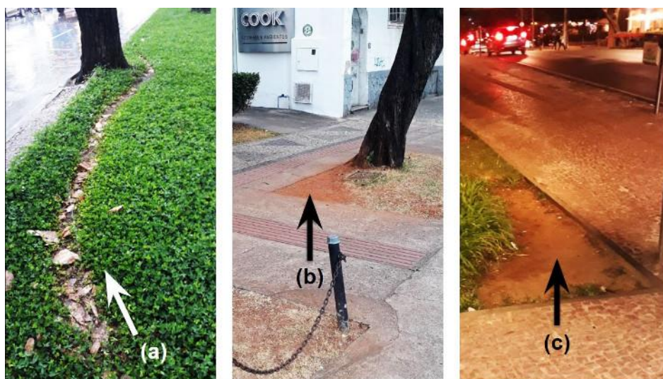
Figura 06: Em Belo Horizonte, caminhos refeitos sobre paisagismo que ignora rotas intuitivas. Crédito: Autores.
