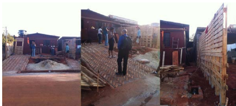
Figura 5: Casa da Ivete Materiais usados na reforma Pedra portuguesa, corpos de prova de concreto, pallets, etc Fonte: programadesejaca.wordpress.com
