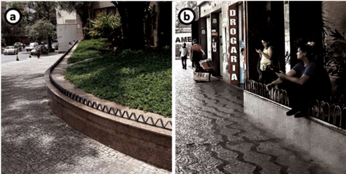
Figura 1: Dispositivo de proteção patrimonial: (a) inibindo o uso e (b) sendo adaptado para permitir utilização. Crédito: Autores.
